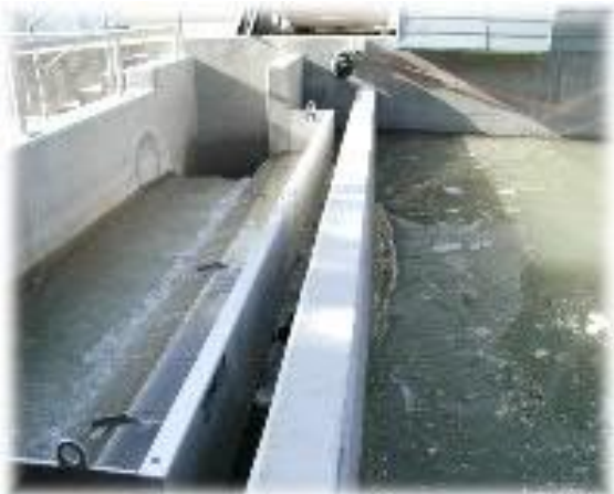
ROTAMAT® pleištinės sekcijinės grotos RoK 2 prie vandens slenksčio
