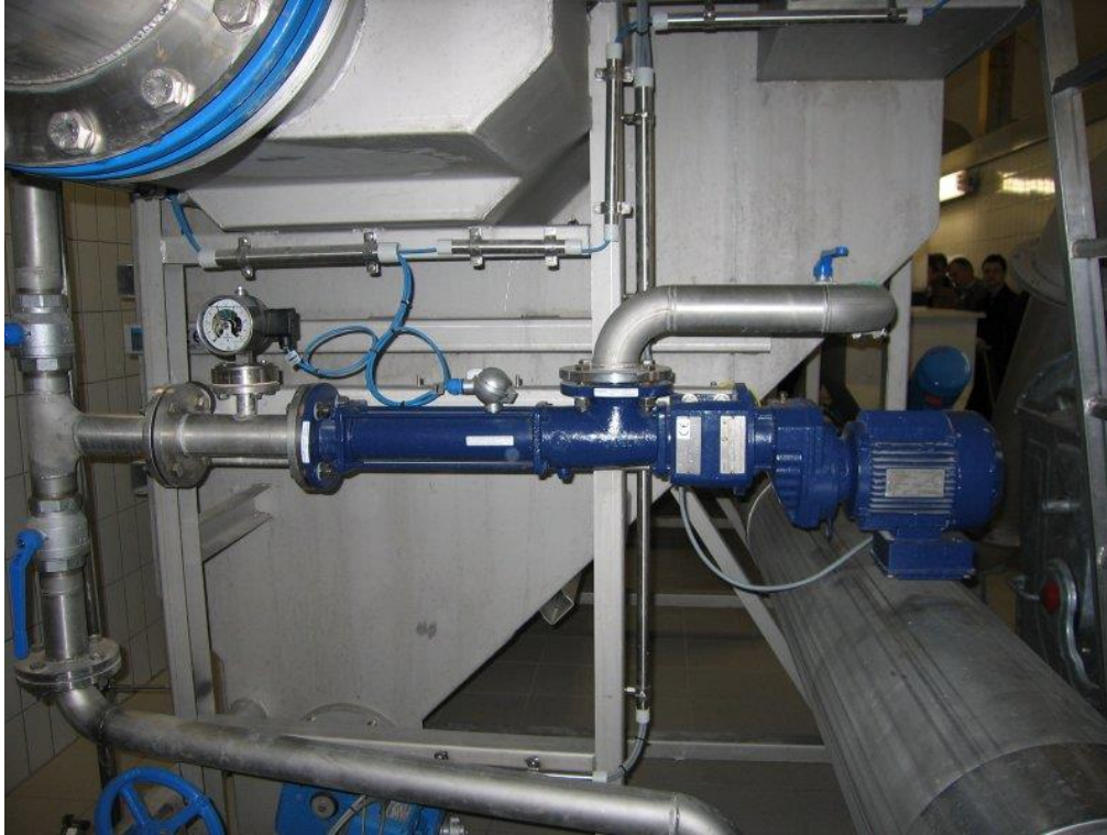
Riebalų šalinimas siurbliu
