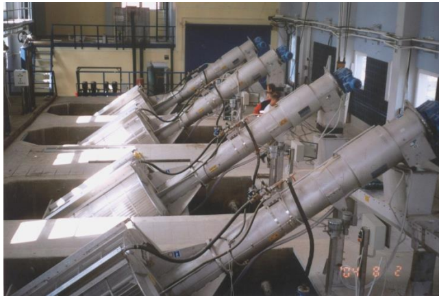
4 kanale įrengti ROTAMAT® būgniniai nešmenų šalinimo įrenginiai su pleišto formos groty akutėmis Ro 2, Rusija
