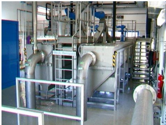
ROTAMAT® išilginė smėliagaudė su smėlio šalinimo sraigtu Ro 6
