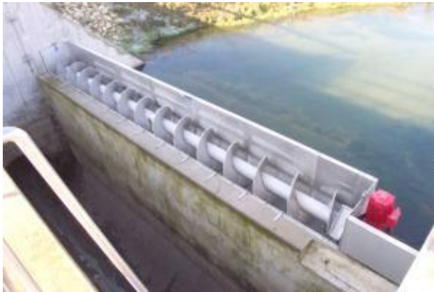
ROTAMAT® grotos paviršinėms nuotekoms RoK 1 prie vandens slenksčio
