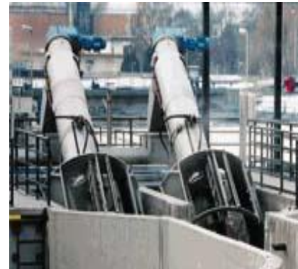
ROTAMAT būgninis nešmenų šalinimo įrenginys Ro 1 įleidimo kanale NVI Budapešte
