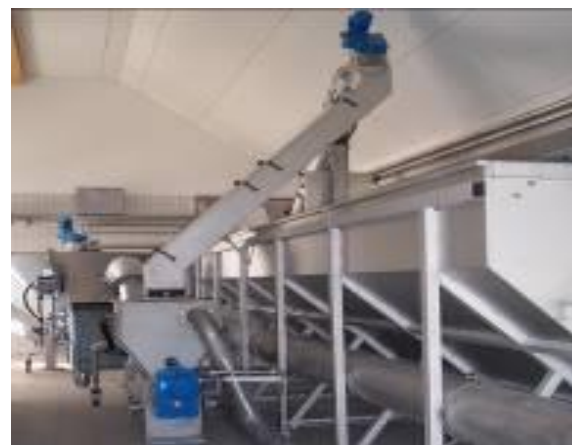
Pilnutinis valymo įrenginys Ro 5 su smėlio ir nešmenų plovimu
