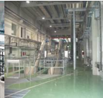
ROTAMAT būgninis nešmenų šalinimo įrenginys Ro 1, sumontuotas NVI Splitė
