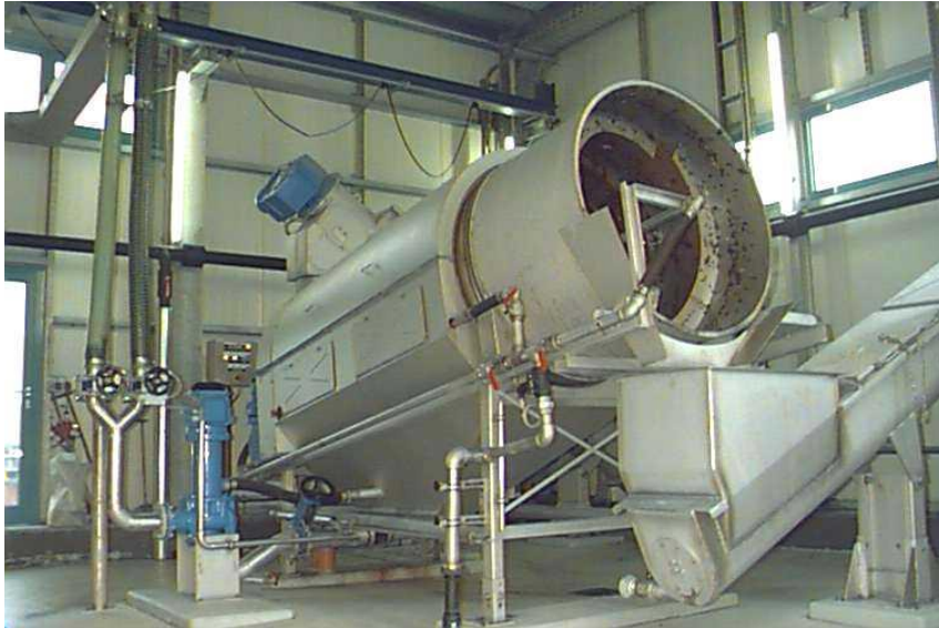
ROTAMAT® plovimo būgnas RoSF 9 NVJ Manheime, Vokietijoje
