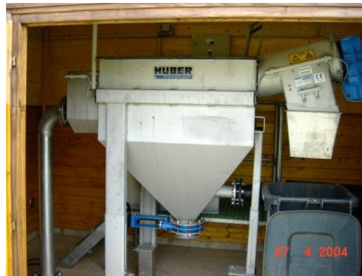
ROTAMAT® kompaktiškas pilnutinio valymo įrenginys MiniCop
