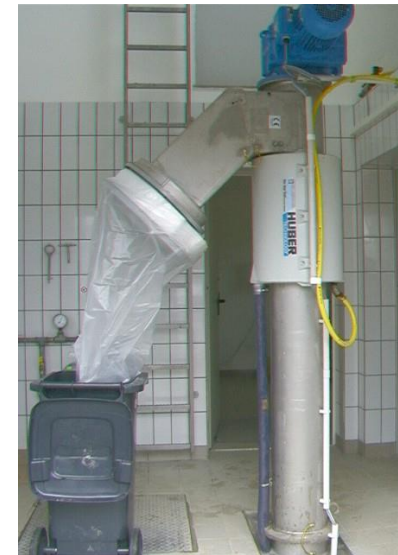
ROTAMAT® grotos su vertikaliu sraigtu RoK 4 perpumpavimo stotyje Vokietijoje
