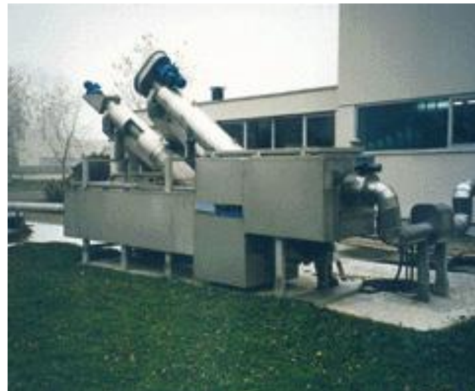
ROTAMAT® septiko priėmimo įrenginys su smėliagaude Ro 3.3
