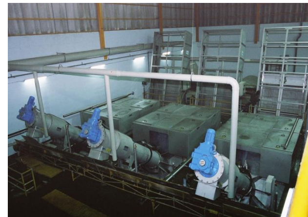
3 Huber būgniniai nešmenų šalinimo įrenginiai su besisukančiu būgnu ir pleišto formos grotų akutėmis, dydis 3000, NVĮ Lisabonoje ( Portugalija)
