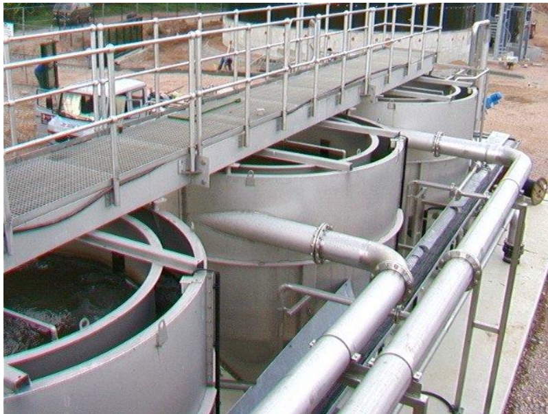
ROTAMAT® apvali smėliagaudė HRSF municipalinių NVJ
