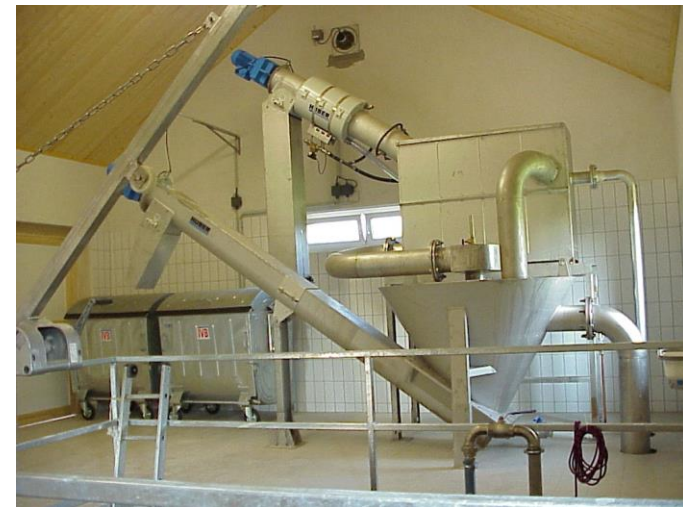
Patalpoje sumontuotas Coanda pilnutinio valymo įrenginys
